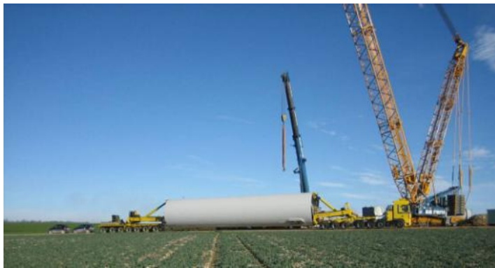
Figure 5 : Illustration du montage d'une éolienne – mât et rotor (source : ABO Wind, 2014)
