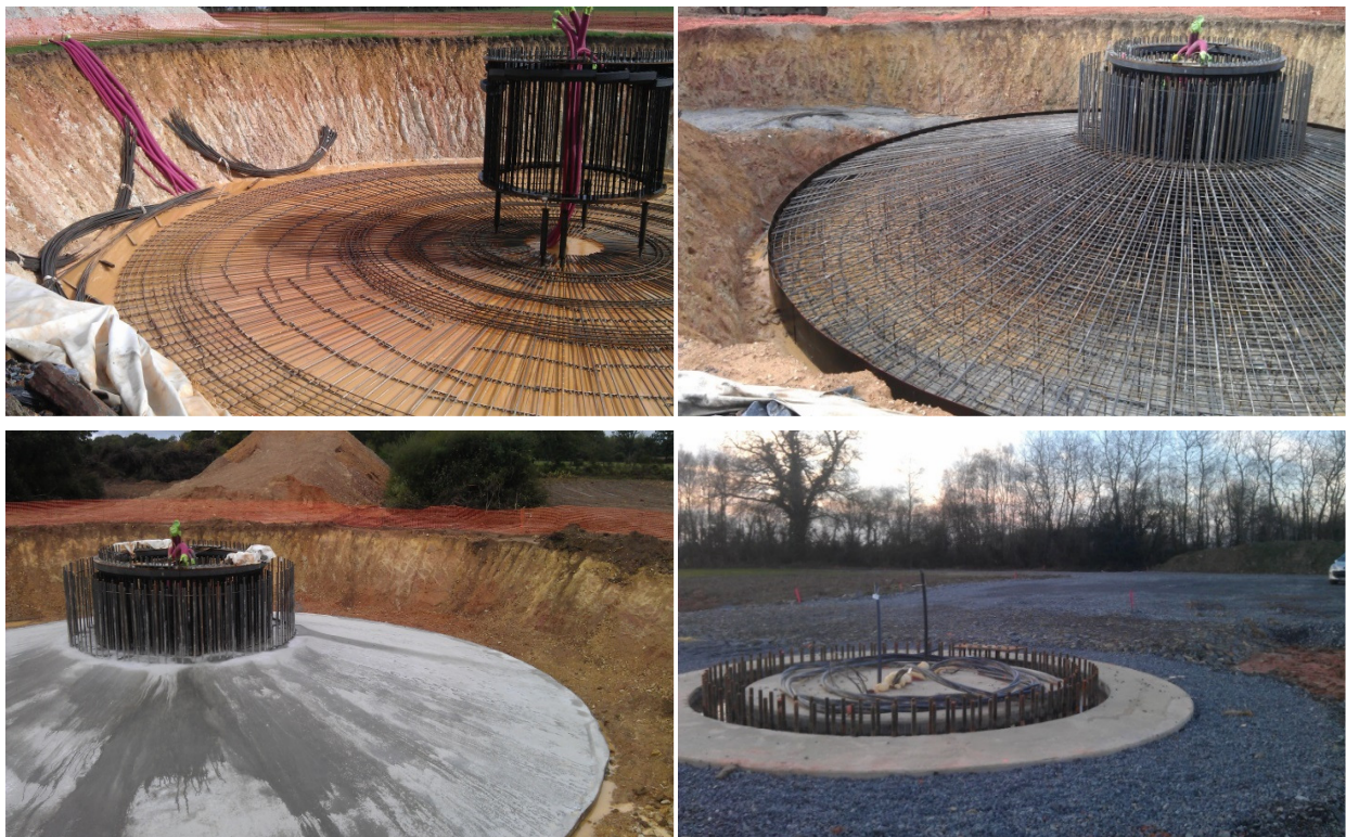
Figure 4 : Illustration du montage d'une éolienne – fondations (source : ABO Wind, 2013)
